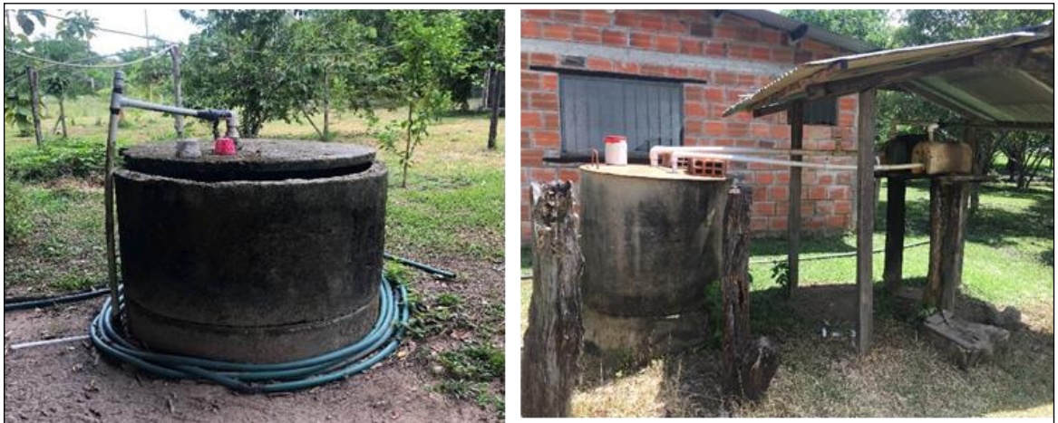
Aljibes protegidos con tapas de concreto en la que sobresalen tuberías de descarga de las bombas.
